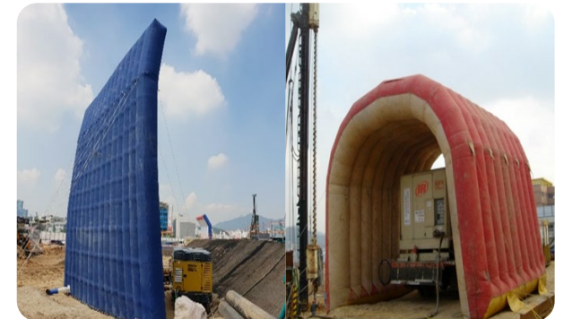
소음 관리를 위한 에어 방음벽 설치 현장
